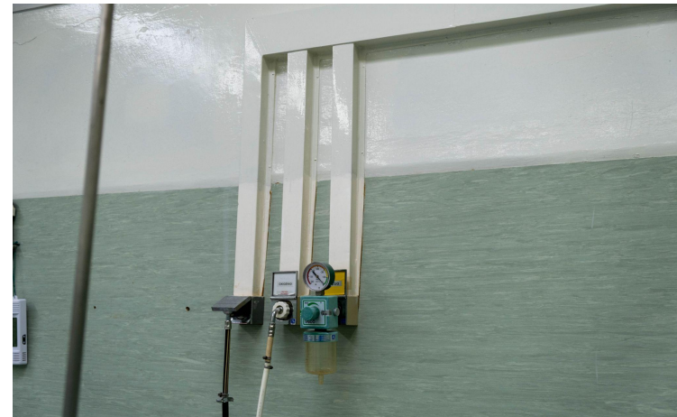
Figure 3 b : Sortie d'oxygène murale (alimentée par le collecteur de cylindres ou le SDGM directement de la centrale d'oxygène)
