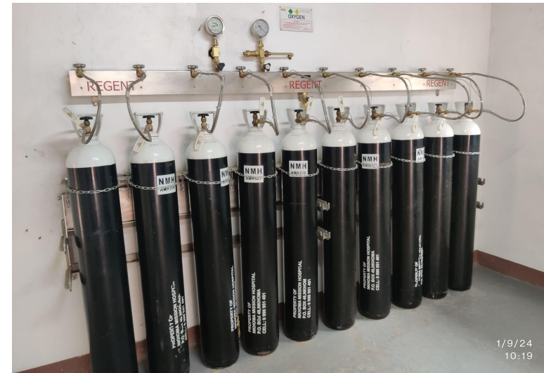
Figure 2 b : Collecteur d'alimentation du cylindre retenu par des chaînes
