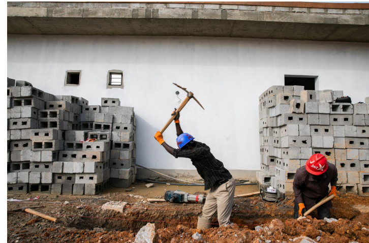
Figura 5b: Abertura de vala para MGPS subterrâneo
