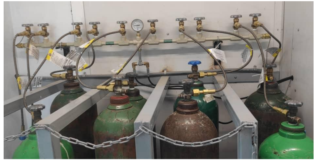
Figura 4b: Exemplo de suportes para cilindros, o método mais seguro de armazenamento
